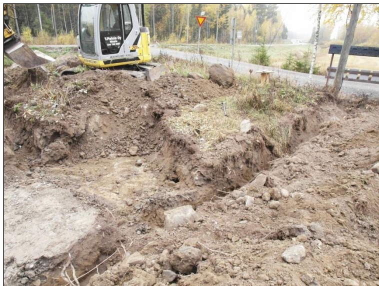
Itä-länsi -suuntainen kaivanto kuvassa oikealla, vasemmalla muuntamon perustuskaivantoa. Kuvattuna koillisesta.
