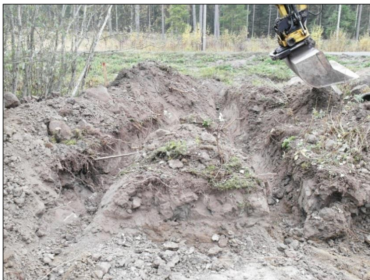
Muuntamosta etelään johtavat kaapeliojat, jotka yhdistyvät eteläisimmäksi kaapeliojaksi. Kuvattu pohjoisesta.
