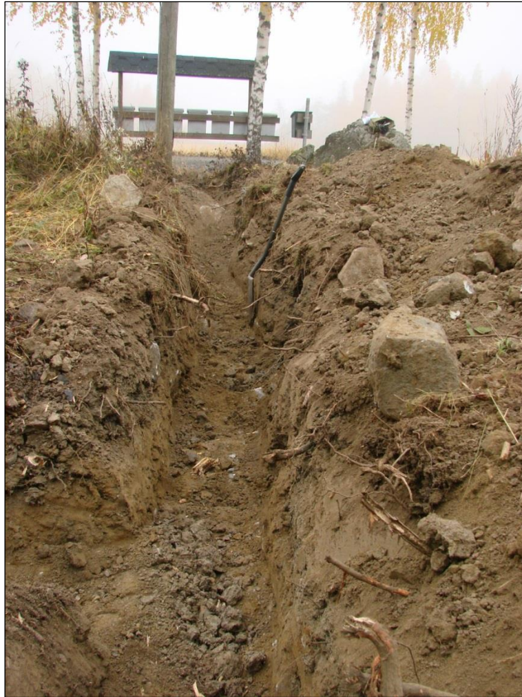
Itä-länsi –suuntainen kaapelikaivanto Priikolintien sähköpylvästä kohti muuntamon perustusmonttua. Kuvattu idästä.
