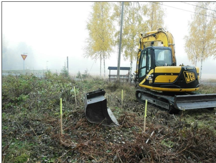
Tuleva muuntamon paikka merkitty puukepeillä, kaivinkoneen kauha keskellä. Kuvattu idästä.
