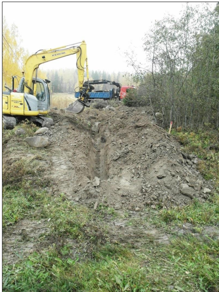
Eteläisin kaapelikaivanto kuvattu etelästä.
