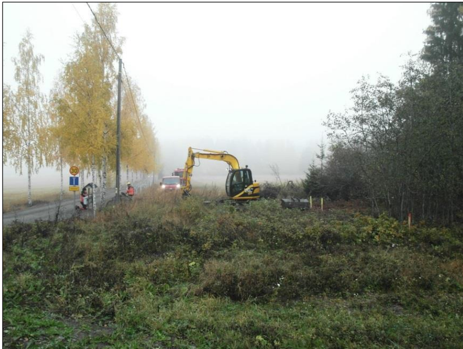
Valvonnassa kaivettavaa osaa muinaisjäännösalueen länsireunalla ennen töiden aloittamista. Kuvattu etelästä.
