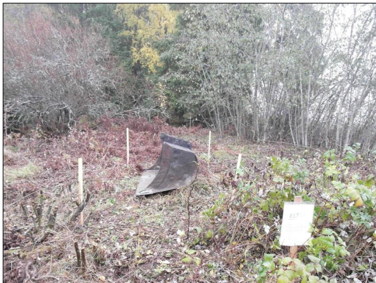
Tuleva muuntamon paikka merkitty maastoon puukepeillä, keskellä kaivinkoneen kauha. kuvattu idästä.
