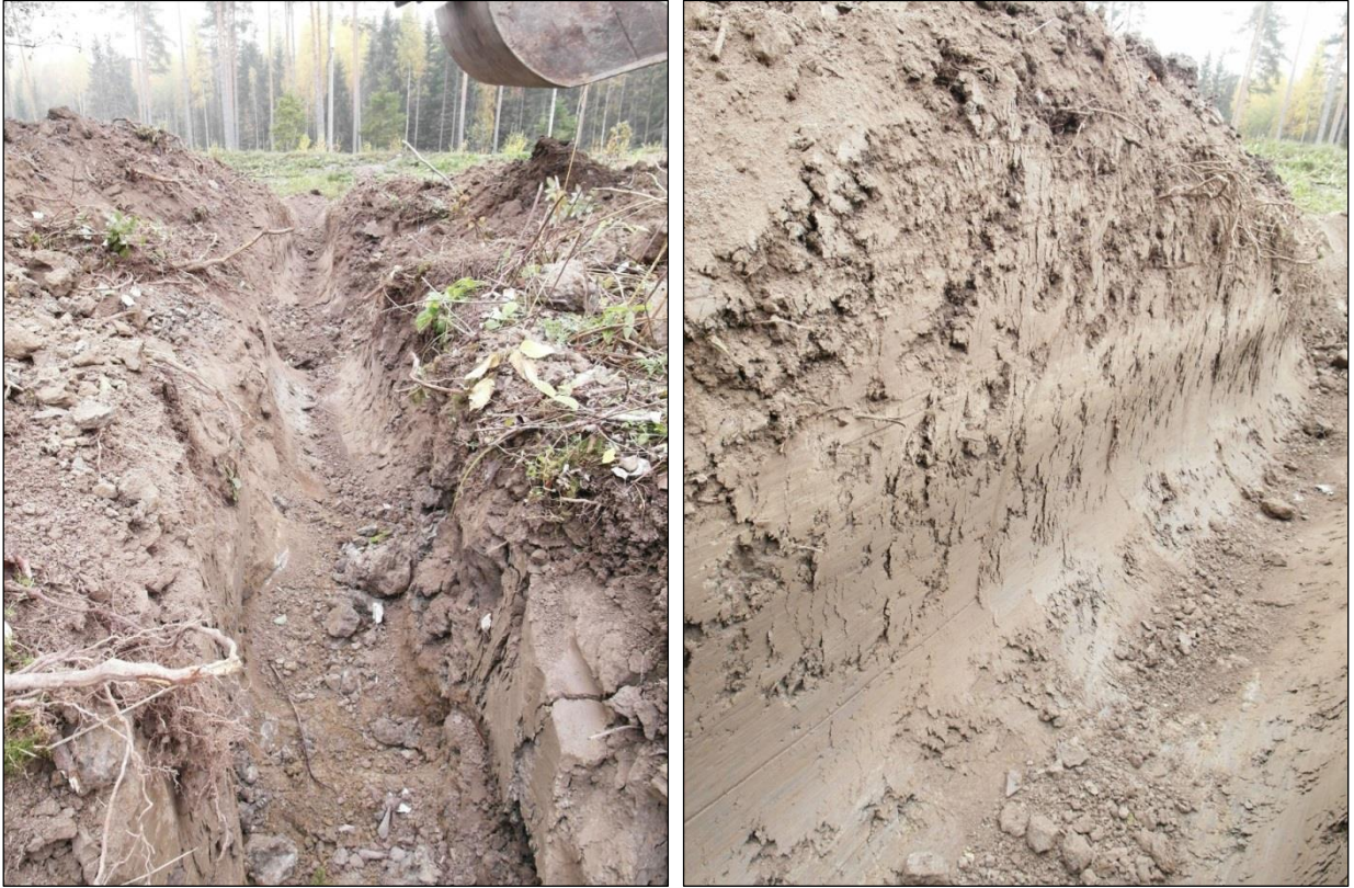
Eteläisin kaapelikaivanto muuntamolta Vesilahdentielle. Vesilahdentieltä pohjoiseen. Kuvattu pohjoisesta. Vasemmalla lähikuva kaivannon länsiseinämästä.
