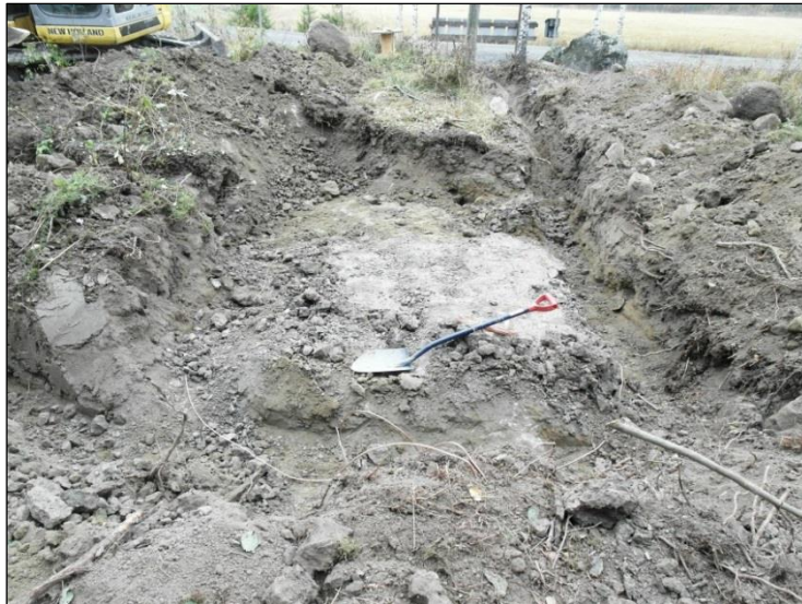
Muuntamon perustusmonttu kuvattu pohjoisesta.
