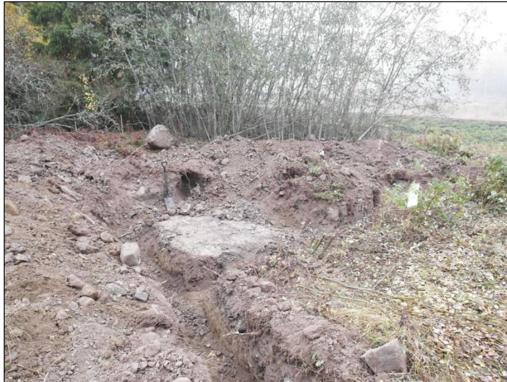
Kaivettu muuntamon perustus ja kaapeliojat kuvattu lännestä.
